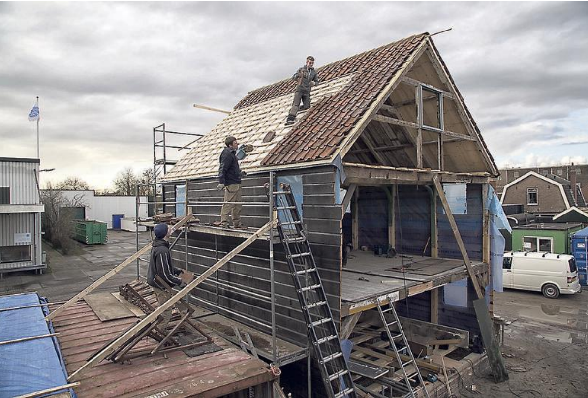
Het 'bouwpakket' wordt in elkaar gezet. Op de steiger staat Bart Nieuwenhuijs.
